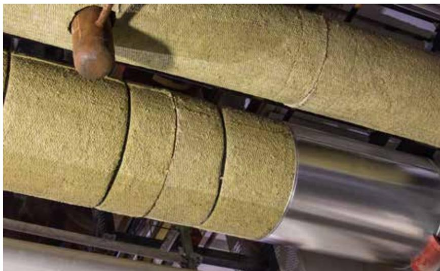
Изоляция высокотемпературного трубопровода одним слоем цилиндров.
